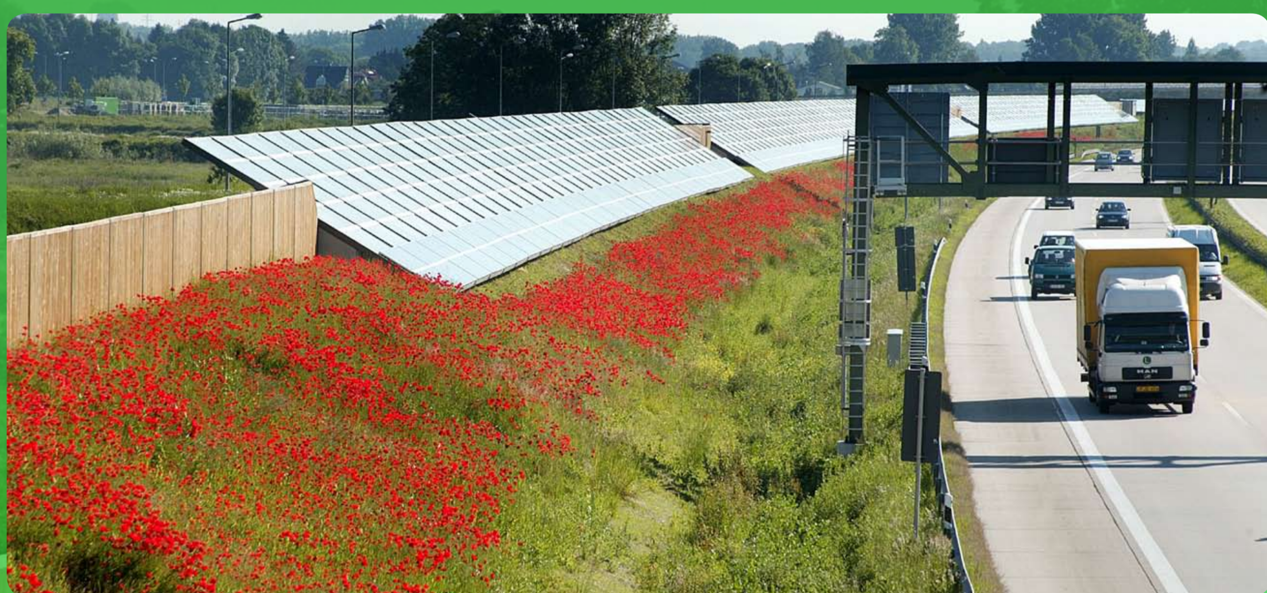
Los paneles fotovoltaicos en las barreras de ruido para el uso de fuentes renovables de energía
