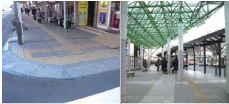
Figure 8 - Dénivellations éliminées sur les trottoirs, guidage en relief pour les déficients visuels, arrêt de bus couvert
