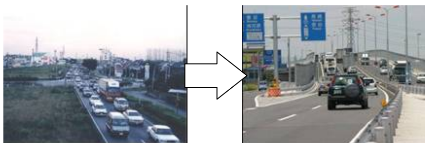
Avant dénivelation de l'intersection
