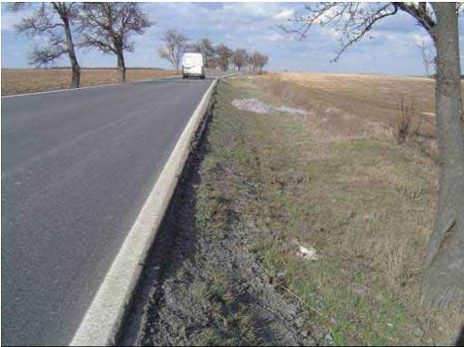
Figure 2. Absence d'accotement sur une route à forte circulation dans la banlieue de Prague.<sup>6</sup>
