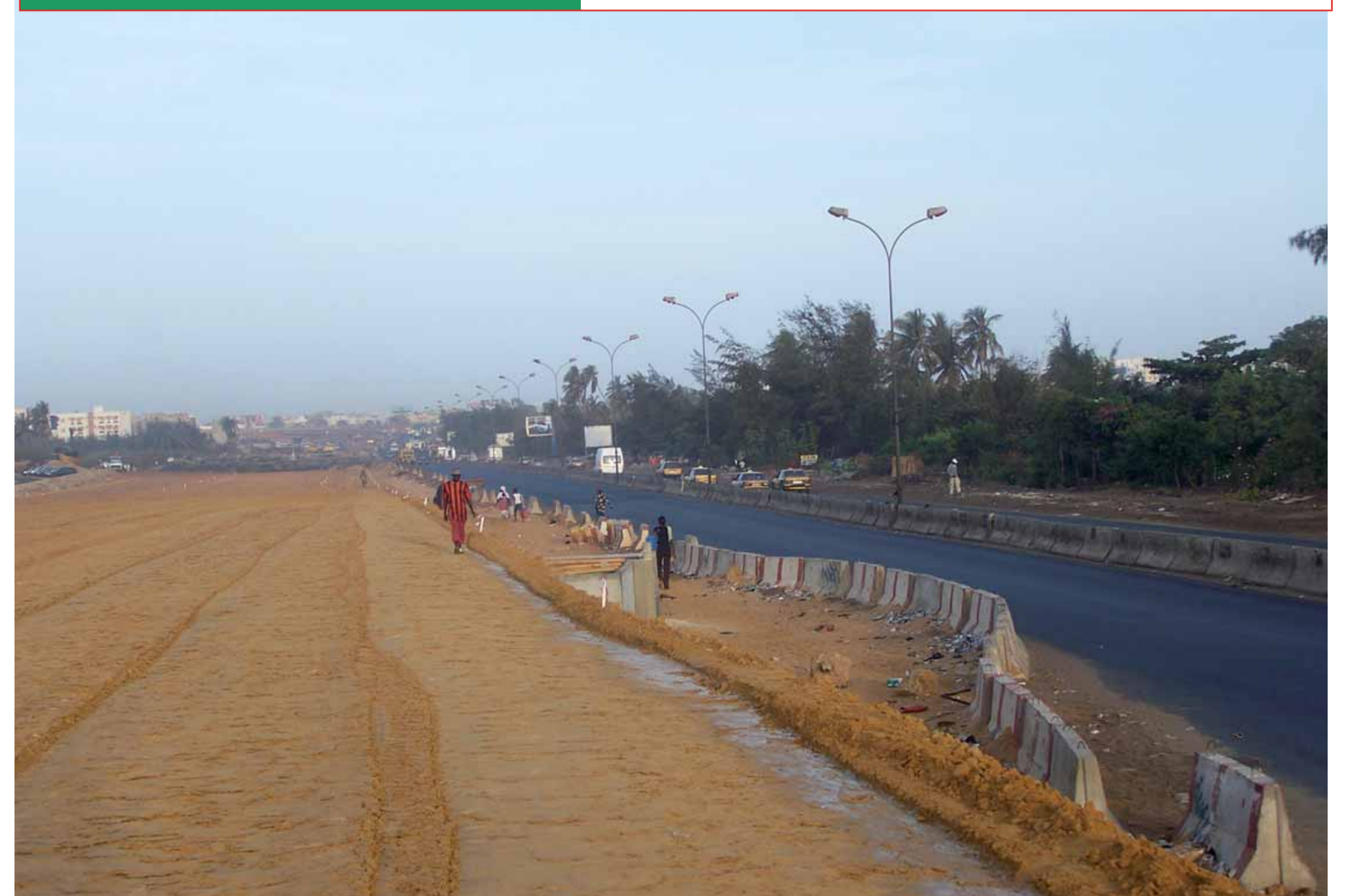
Construction de la première autoroute à péage - Construction of the first toll highway (2008) © Rignese
