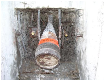
(d) Concrete removal
