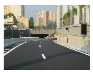
FIGURE 7. TUNNEL CLOSURE SYSTEM IMPLEMENTED AT THE ENTRANCE OF THE TOULON TUNNEL – FRANCE
