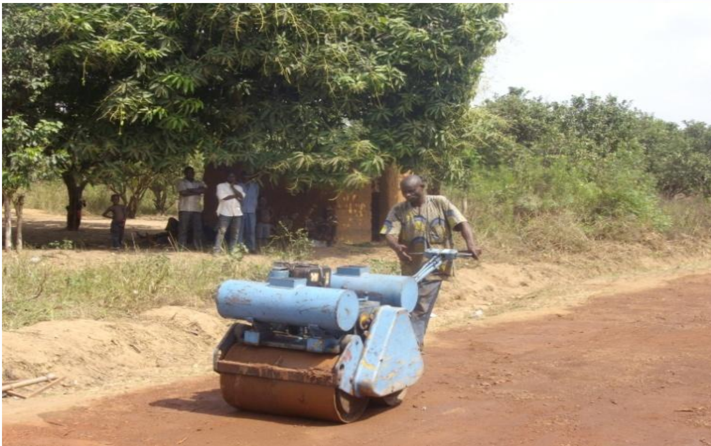
Photo 6 – Compactage du matériau mis en place
