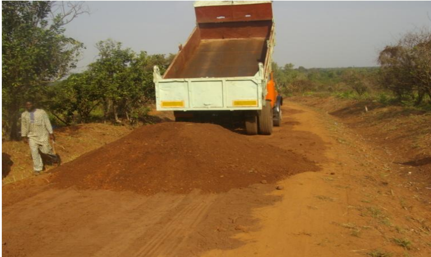
Photo 3 – Un camion benne déposant de la latérite
