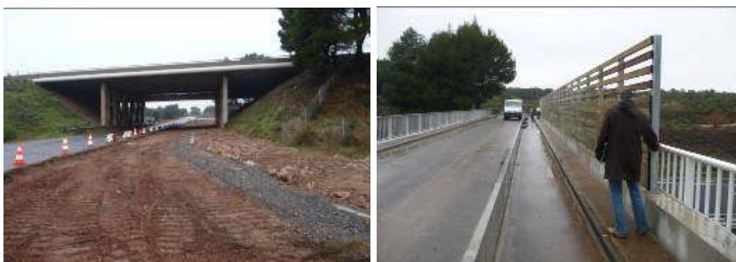
Figure 13 – Travaux de conversion d'un passage inférieur (gauche) et supérieur (droite) sur A9
