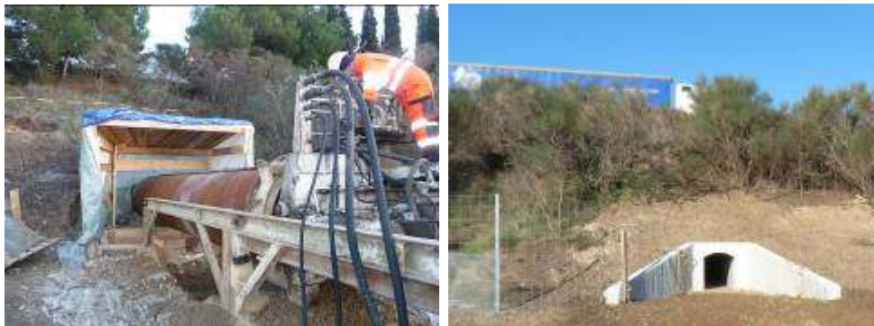
Figure 11 – Travaux de fonçage d'une buse en 1200 mm (gauche) et de finition (bas) sur A7
