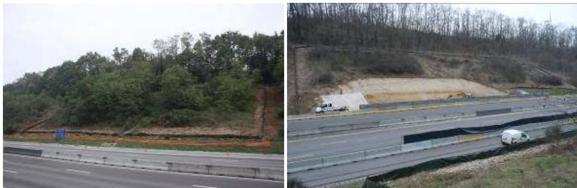
Figure 12 – Plan de sauvegarde (gauche) et démarrage des travaux (droite) de l'éco-pont sur A7
