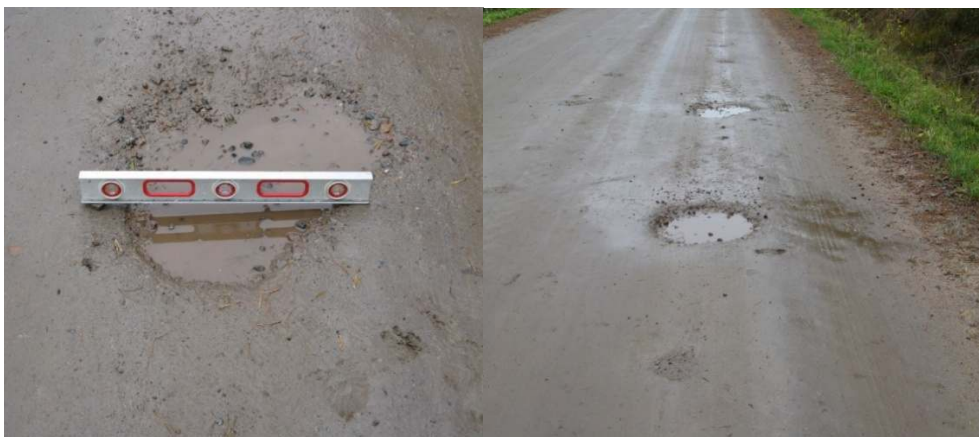
Figure 10. Il y avait de grandes flaches dans la ligne de conduite de la chaussée 18613.
