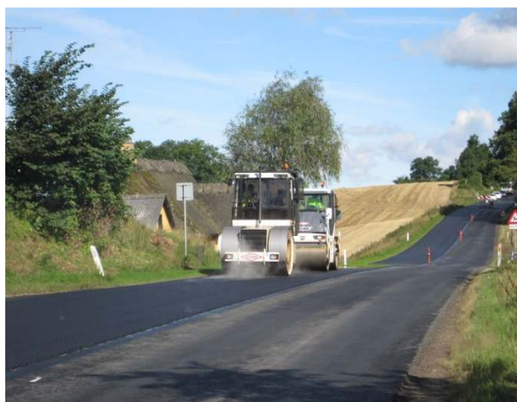
Figure 12 - Construction de Chaussées fines Réductrices de bruit (Danemark)
