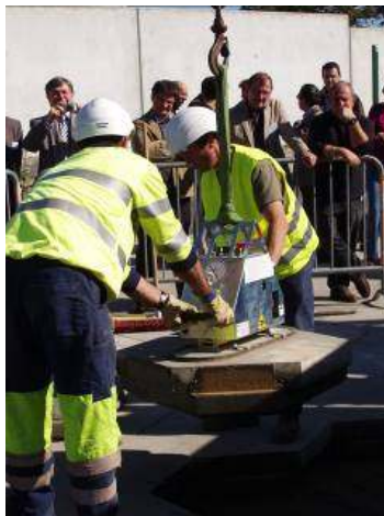
Figure 11 - Pause d'une Chaussée Urbaine Démontable (France)
