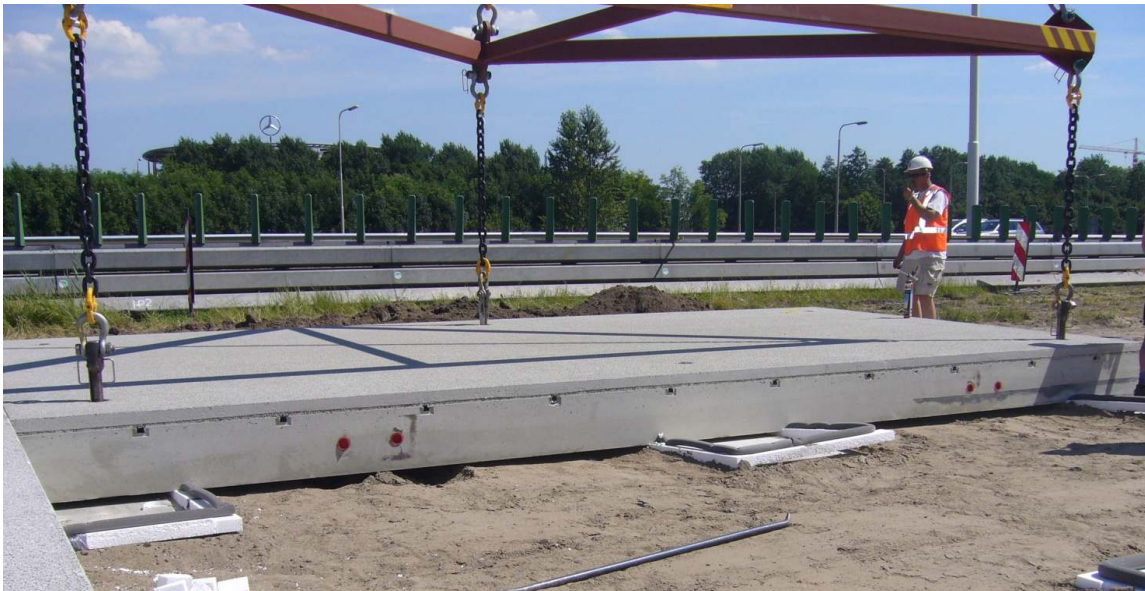
Figure 6 - Une section Modieslab en cours de pose (Pays-Bas).
