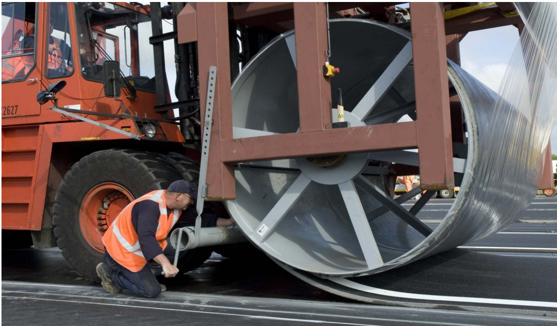
Figure 7 - Section de test Rollpave (Pays-Bas)
