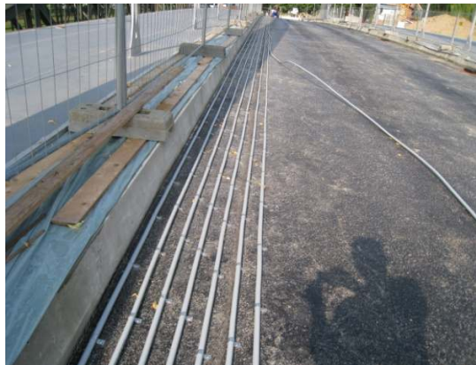
Figure 10 - Mise en place des tuyaux de chauffage sur un tablier de pont (Allemagne)
