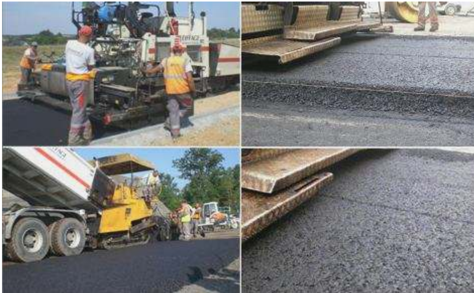
Figure 7 – Mise en œuvre d'une GB5 ® 0/14 avec granulats Noubleau et bitume semi-soufflé 35/45B près de Tours. Densité en place: 96,4% ; module mesuré en compression diamétrale E^*(15^{\circ}\text{C}-10\text{Hz}) : 14100MPa.
