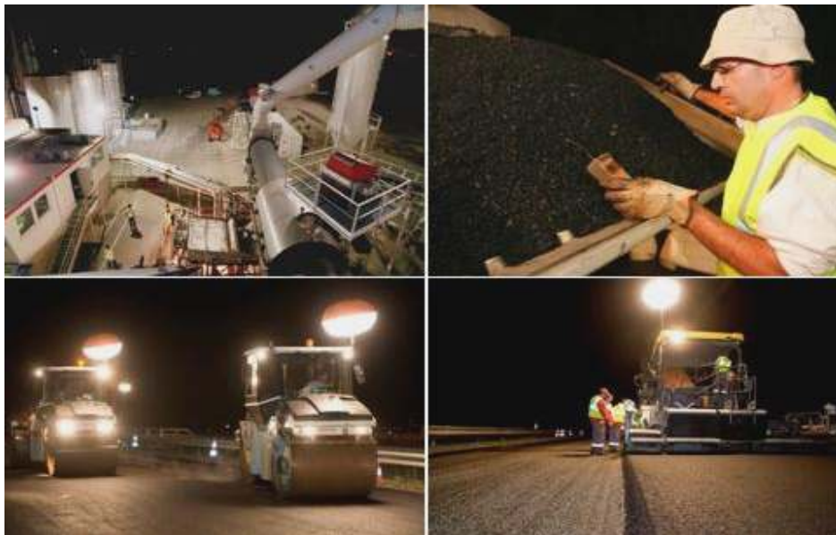
Figure 8 – Mise en œuvre d'une GB5 ® 0/14 avec granulats Cemex et bitume semi-soufflé 35/45B avec 35% d'agrégats d'enrobé recyclé près de Toulouse. Densité en place: 97% ; module mesuré en compression diamétrale E^*(15^{\circ}\text{C}-10\text{Hz}) : 15100MPa.
