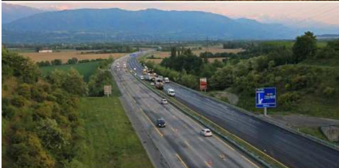
Figure 9 – Chantier de 12 000 tonnes de GB5 ® 0/14, au liant modifié au SBS Biprene ® , sur autoroute concédée A43 (AREA, section Chignin-Francin) en région alpine.
