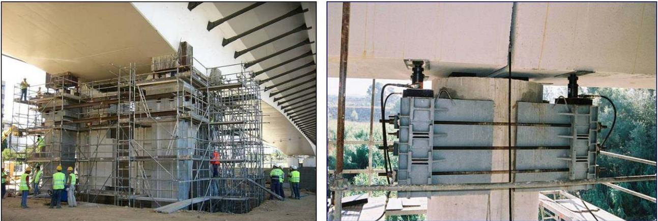
*Figura 9. Ejemplo de actuación de mantenimiento especializado para la sustitución de aparatos de apoyo.*
