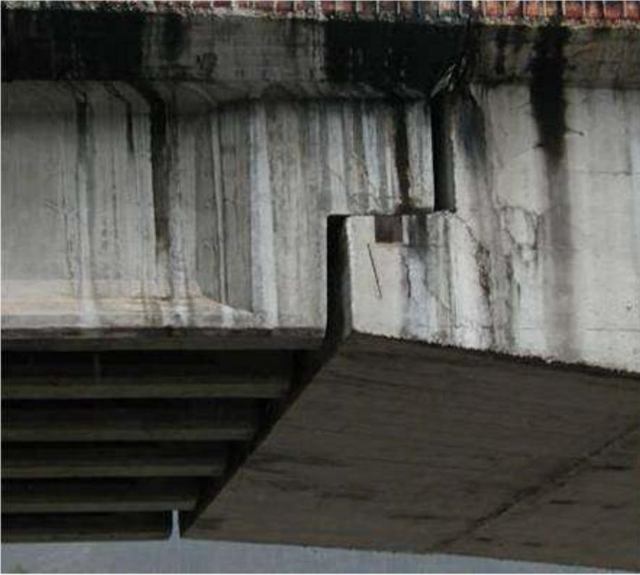
*Figura 8. Ejemplo de apoyo a media madera, con gran dificultad de inspección.*
