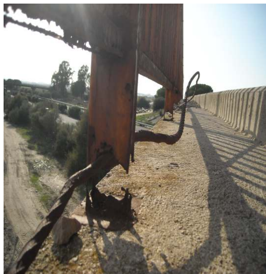
Figura 7 - Pérdida de sección de acero en barandilla y abollamiento en defensa metálica
