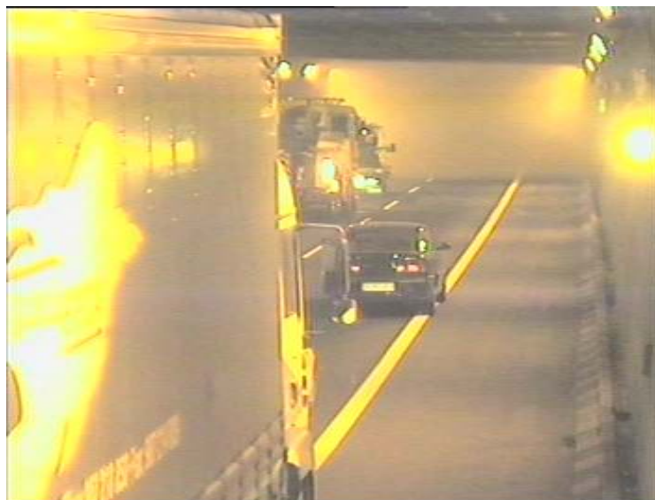
“Foto 5 – Control de humos por la ventilación”
