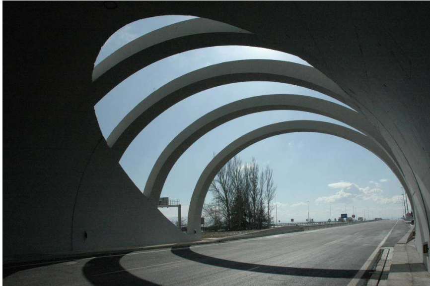
“Foto 7 – Salida túnel 3”
