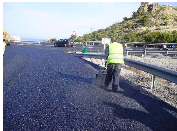
Fotografía 17 - Esparcido de la bauxita
