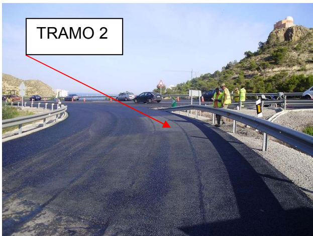
Fotografía 20 – Tramos de prueba inicio
