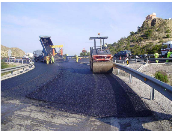
Fotografía 16 - Extendido de la mezcla
