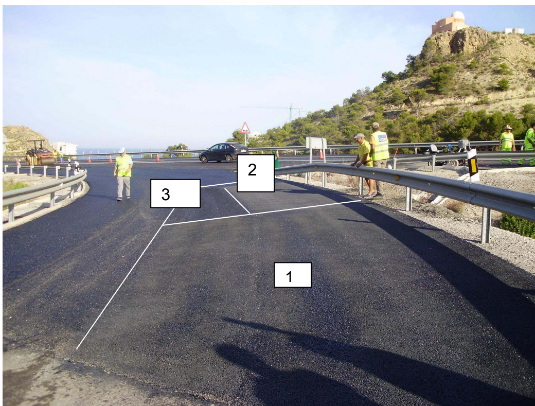
Fotografía 18 - Disposición y aspecto de los tramos con bauxita
