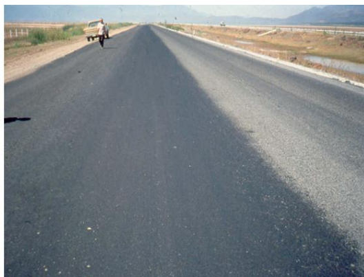
Figura 10 - Capa de rodamiento de concreto asfáltico (10 cm). Carretera Guadalajara -
