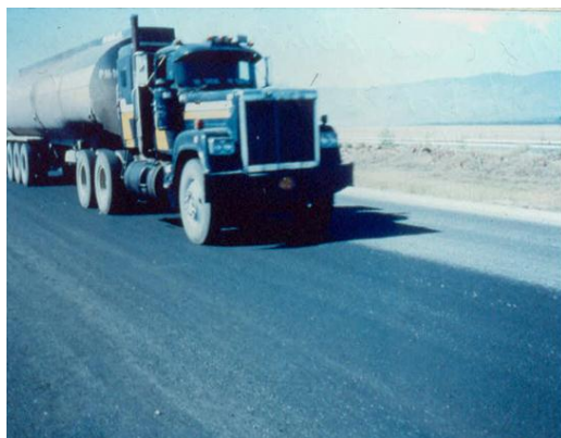
Figura 9 - Compactación de la capa de base. Misma grava de la figura 6. Carretera Guadalajara - Colima
