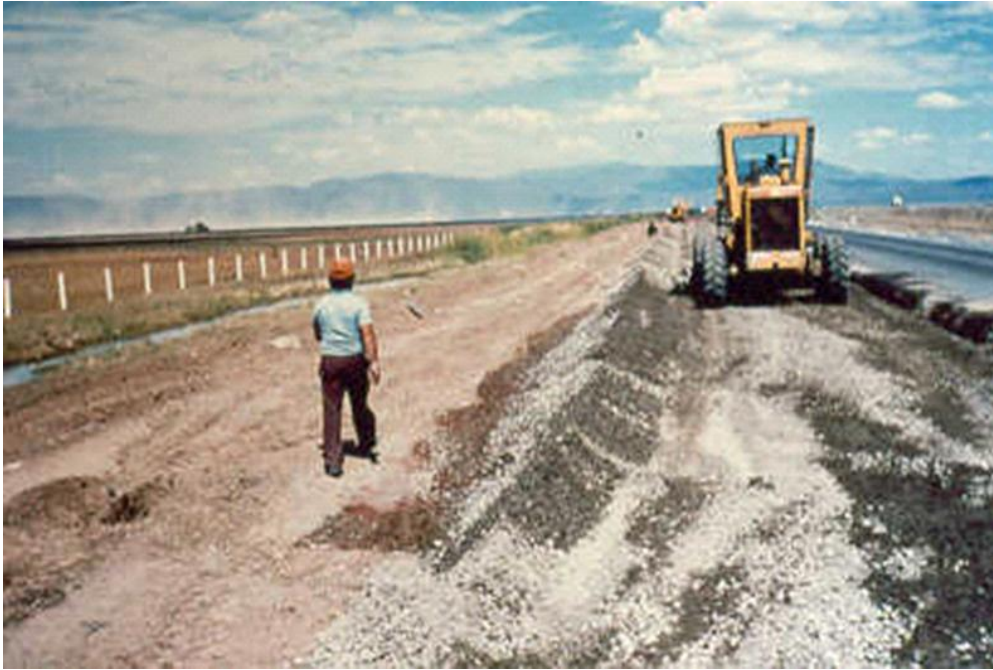
Figura 8 - Mezcla de los elementos del RCC de la figura 7. Carretera Guadalajara – Colima
