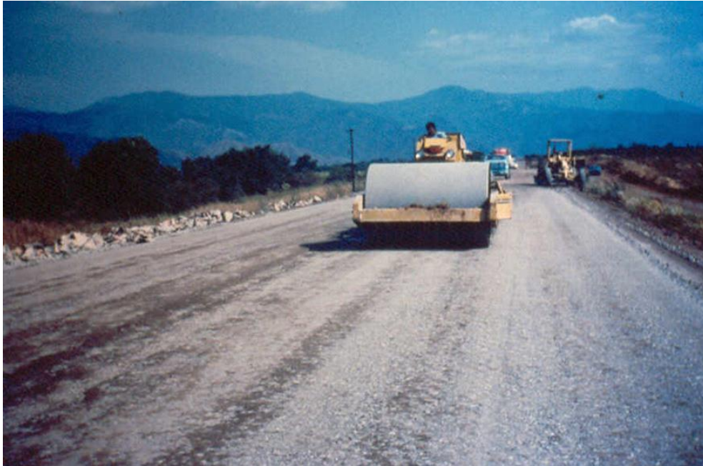
Figura 14 - Compactación del RCC (capa de sub-base) del pavimento con "sección invertida" Carretera Tepic - Aguamilpa. Contenido de cemento Portland: 10% cm; espesor: 25 cm. Aluvión de grava
