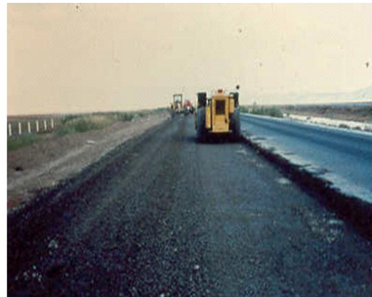
Figura 9 - Compactación de la capa de base. Misma grava de la figura 6. Carretera Guadalajara - Colima
