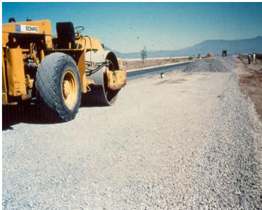
Figura 9 - Compactación de la capa de base. Misma grava de la figura 6. Carretera Guadalajara - Colima
