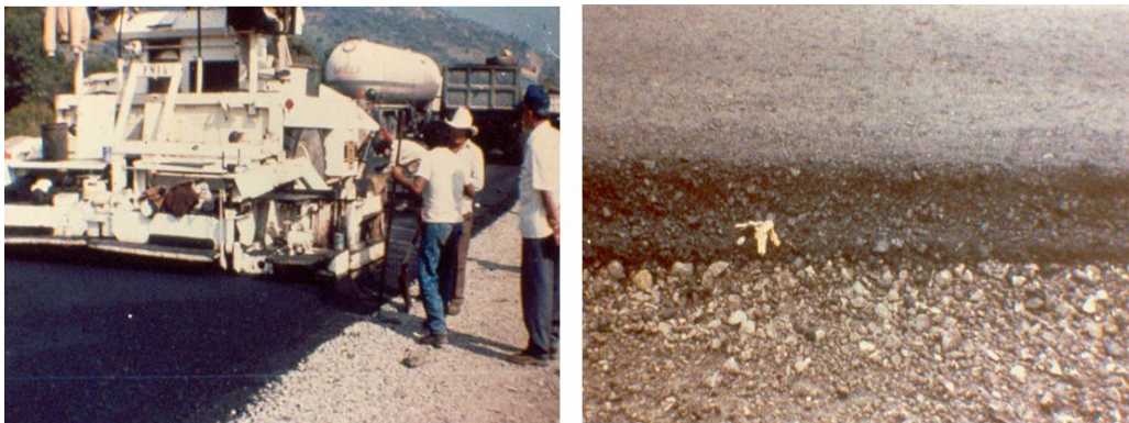
Figura 12 - Compactación del concreto asfáltico (10 cm) y vista de la “sección invertida” completa. Carretera Puebla – Orizaba
