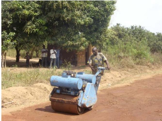
Photo 5 – Compactage du matériau mis en place
