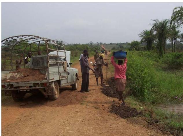
Photo 1 – Véhicule bâché et ouvriers déposant du matériau pour combler les dégradations
