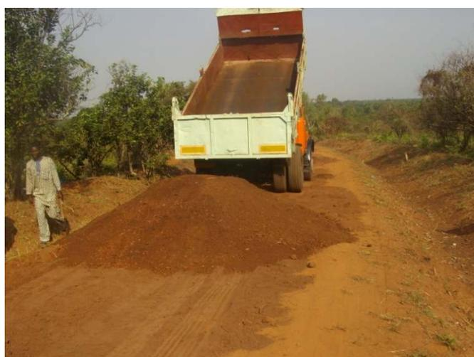
Photo 2 – Un camion benne déposant de la latérite
