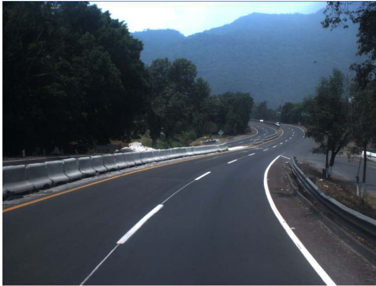
FIGURA 2 Barrera Central de Concreto Discontinua en el Segmento 1
