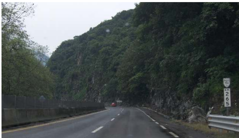
FIGURA 4 Talud de Corte en el Segmento 3
