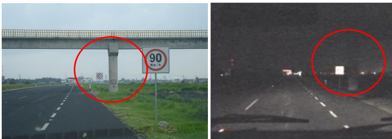
Figura 4 - Comparativa de visibilidad de una estructura durante el día y en condiciones nocturnas.
