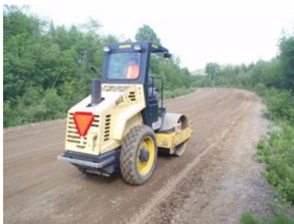
Figure 7 - Rouleau compresseur servant à la compaction de la section référence et de celle stabilisée
