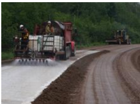
Figure 6 - Épandage de la couche inférieure (profondeur de 5 cm) de l'agent stabilisant sur la partie gauche de la route
