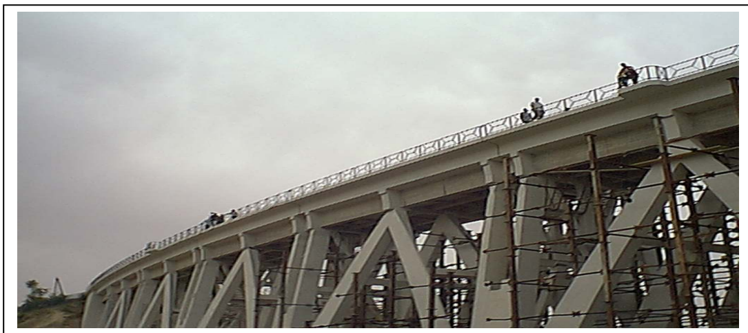
Figure 3 - Premières applications des matériaux composites sur pont à Constantine
