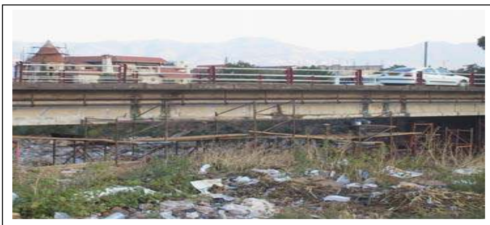
Figure 6 - Vue du pont d'Ighezer Amokrane (Bejaia)
