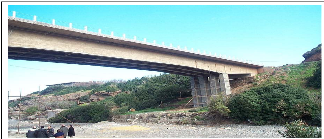
Figure 7 - Vue sur pont sur oued Oumazer avant réhabilitation
