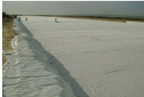
Photos 4 – Etalage de géotextile dans sens le sens longitudinal et transversal.
