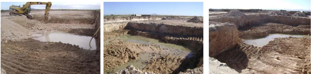
Photo 2 – Phase 1 : Excavation sur une profondeur de 1.35 à 1.5m.
