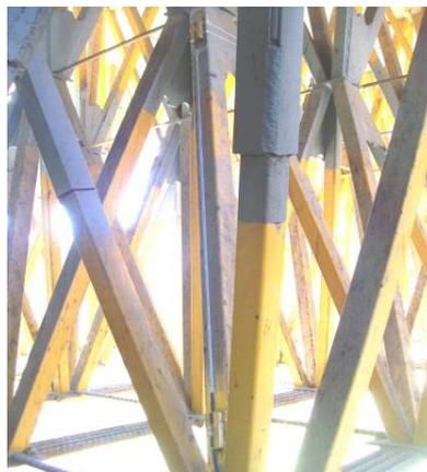
*Figura 4-Instalación de las cuerdas ópticas en los perfiles tubulares*
