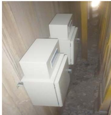
*Figura 6-Instalación de las estaciones de monitorización*
