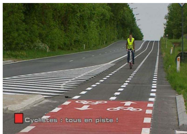
Figure 16- Figurine « 2 Roues » pour la rase campagne à réaliser avec les mêmes dimensions que celles du milieu urbain
