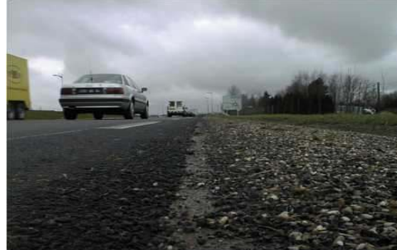
Figure 5 - deux exemples de problème de manque de possibilité d'évitement et de récupération
