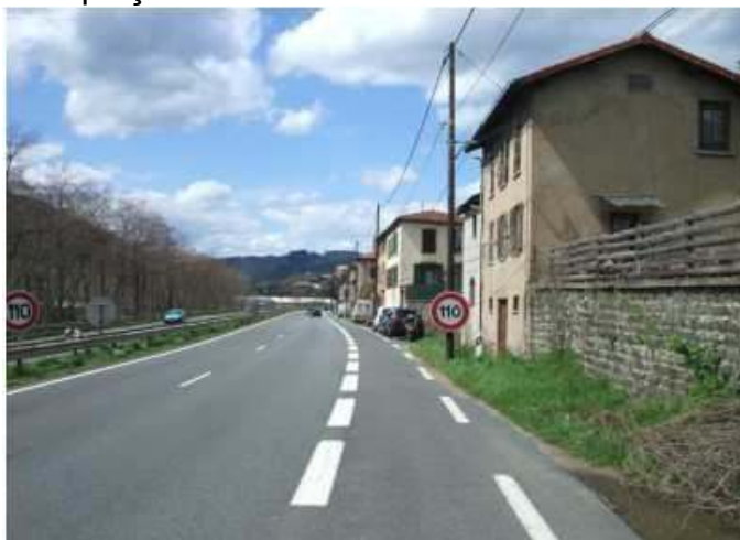
Figure 7 - un exemple de problème de manque de cohérence de tous les éléments de la route et de son environnement
