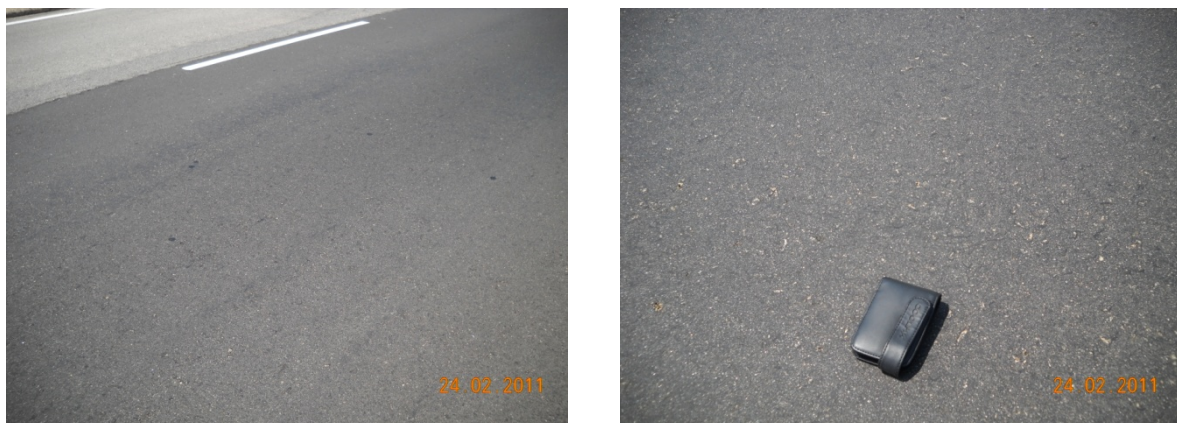
Figure 8: saignements au niveau du HIPR avec plus de 0,3% rajeunissement agent
