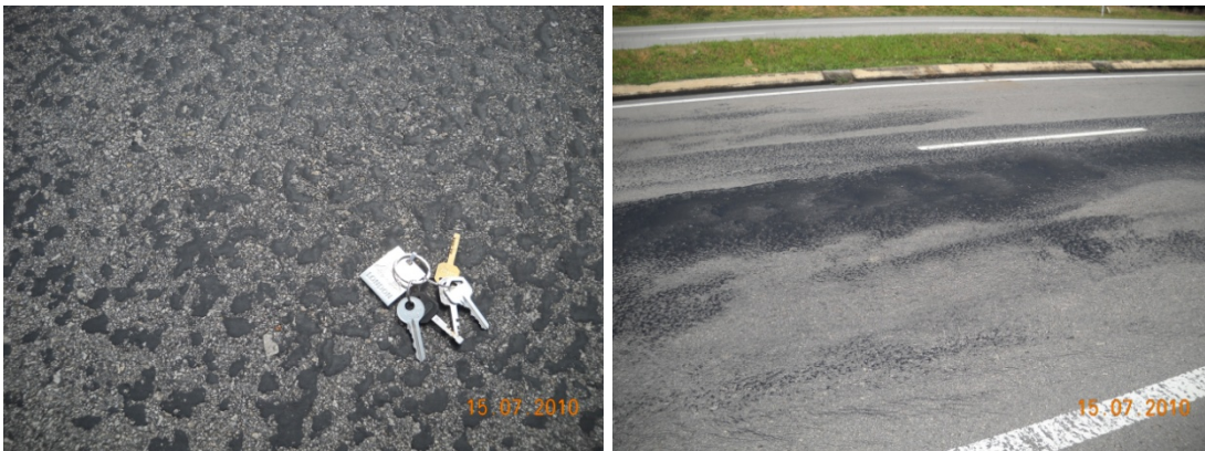
Figure 2: Saignement nouvellement construit Lebuh AMJ
