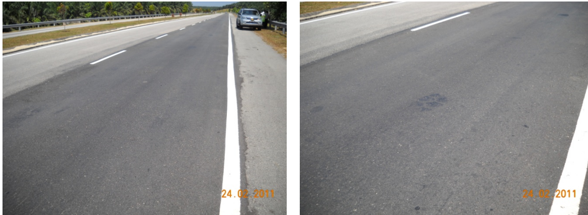
Figure 9: saignement apparent à la HIPR avec plus de 0,5% rajeunissement agent
