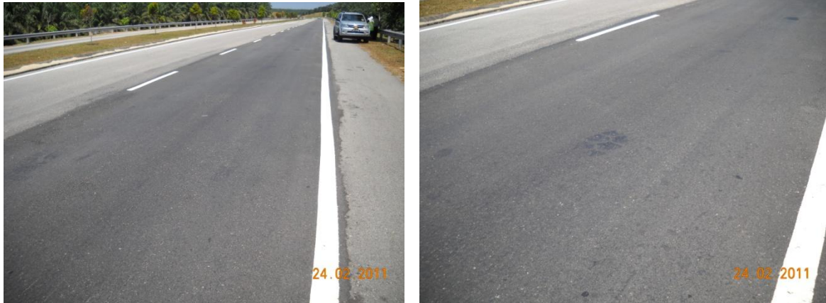
Figura 9 - sangrado aparente en el HIPR con la adición de 0,5% agente rejuvenecedor
