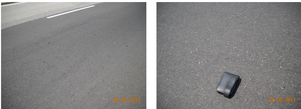
Figura 8 - Sangrado en el HIPR con la adición de 0,3% agente rejuvenecedor
