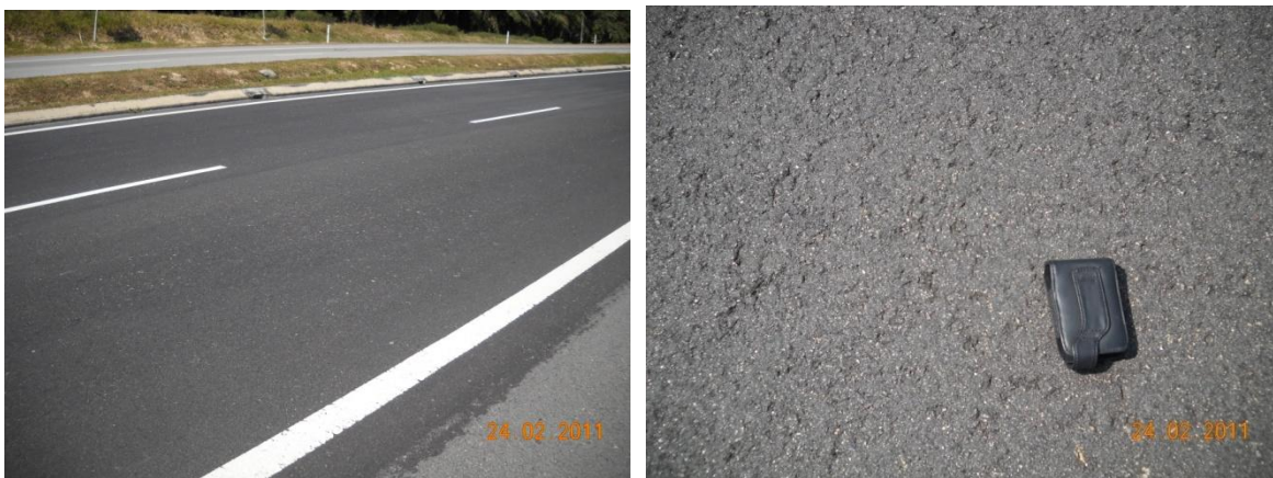
Figura 7 - la superficie del pavimento en la HIPR sin adición de agente rejuvenecedor
