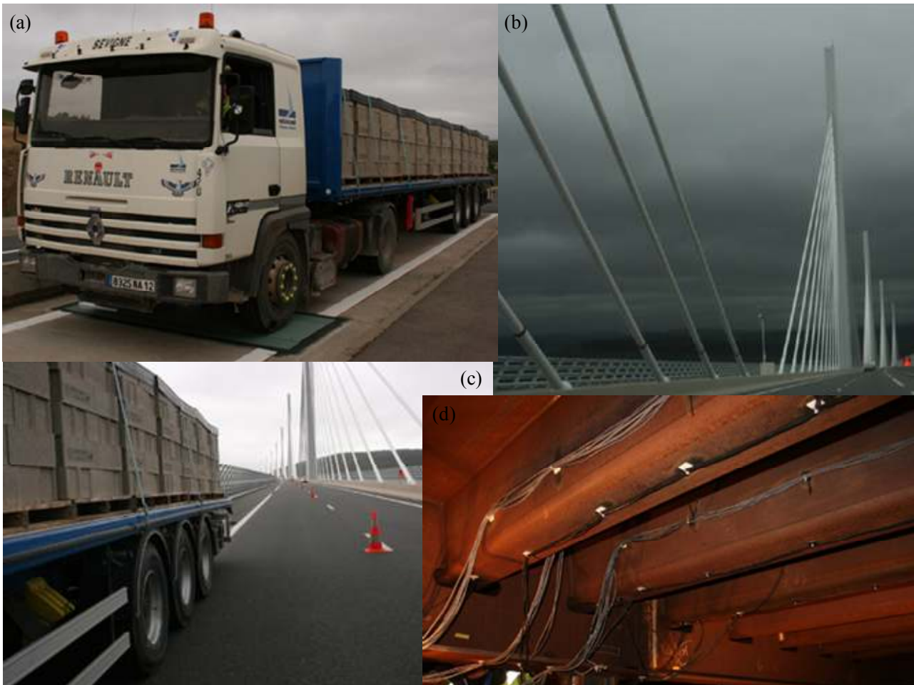
Figure 8 - Photos du viaduc de Millau durant les investigations. (a) camion de chargement lors du pesage des essieux ; (b) vue du viaduc ; (c) camion de chargement sur le viaduc de Millau ; (d) augets et pièces de pont instrumentés de jauges dans le caisson métallique
