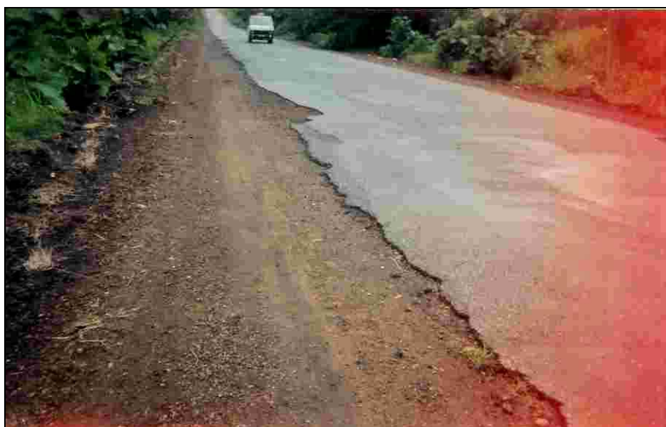
Figure 2- L'état de la route internationale Lomé-Cinkassé On peut voir sur cette photo l'état de dégradation poussée de la chaussée dont le rétrécissement est dû à la disparition de l'asphalte par endroits.
