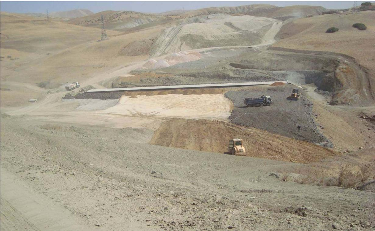
**Photo 3** – réalisation du BRGH du remblai R32
