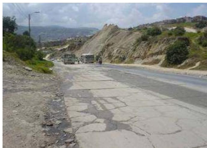
**Fotografía 2. Vía deteriorada por presencia de nivel freático, Vía Usme; Colombia**
