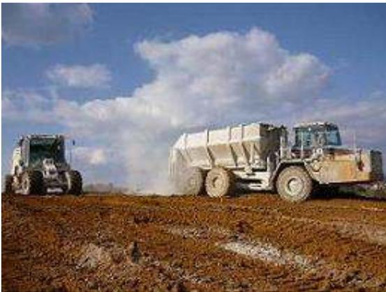
Figure 13 - Traitement du limon au stock – épandage et malaxage
