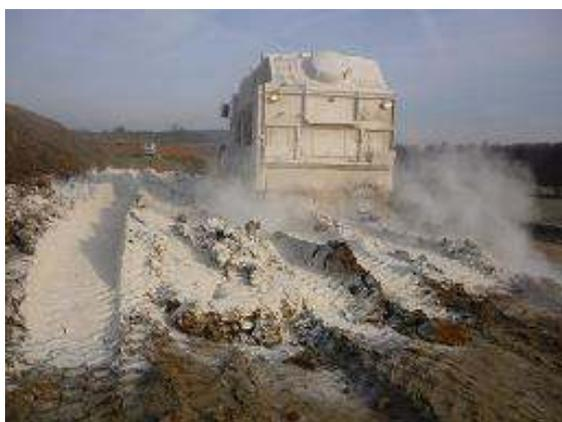
Figure 15 - Epandage de la chaux sur l'argile
