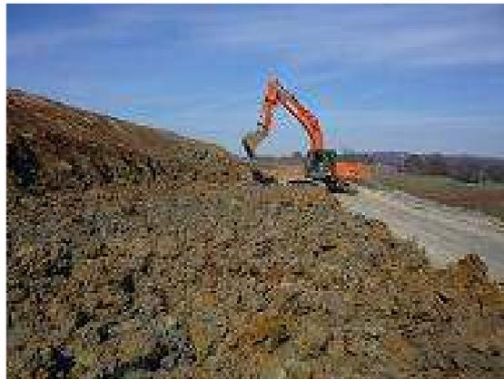
Figure 14 - Scarification des argiles sur la section courante de la RD438
