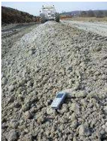
Figure 19 - Mouture 0/31.5mm obtenue sur l'argile
