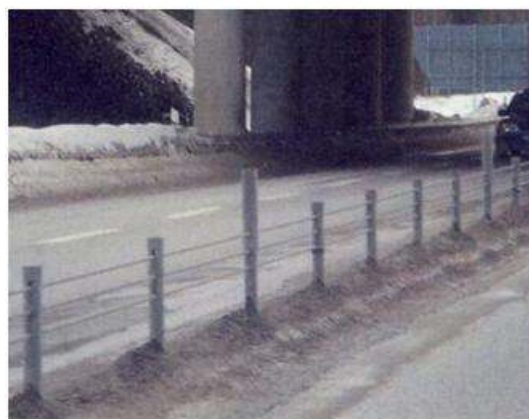
Photo7 Sweden (Luleå) 2+1 road
