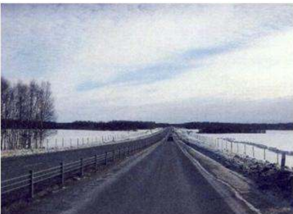
Photo6 Sweden (Luleå) 2+1 road
