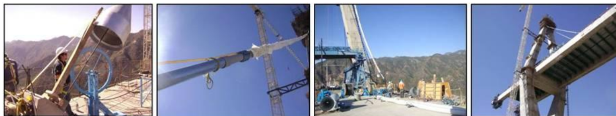
Figura 23 - Instalación de vainas
