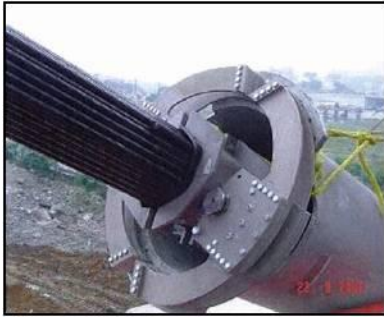
Figura 25 - Amortiguador de Fricción
