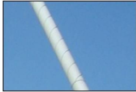
Figura 26 - Tubo funda de tirante con espiral
