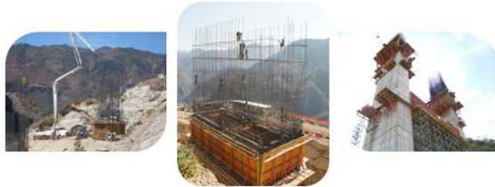
Figura 10 - Armado y colado en apoyos
