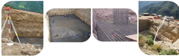
Figura 7 - Armado y colado de zapatas
