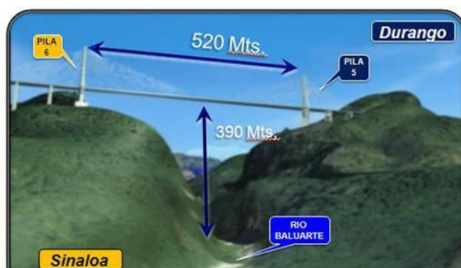
Figura 3 - Perspectiva del puente baluarte
