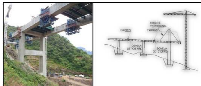
Figura 15 - Dovelas de cierre en doble voladizo
