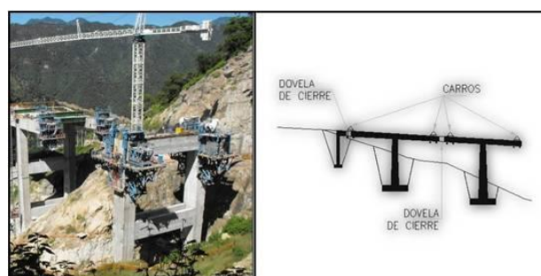
Figura 14 - Construcción de doble voladizo
