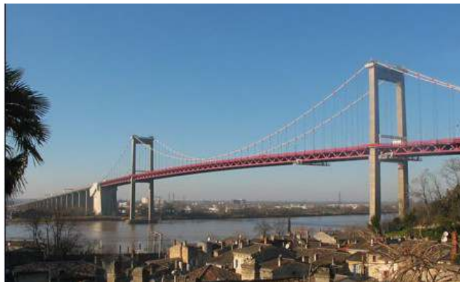
Figure 5 -Vue du pont depuis Lormont-source - Site du Routard
