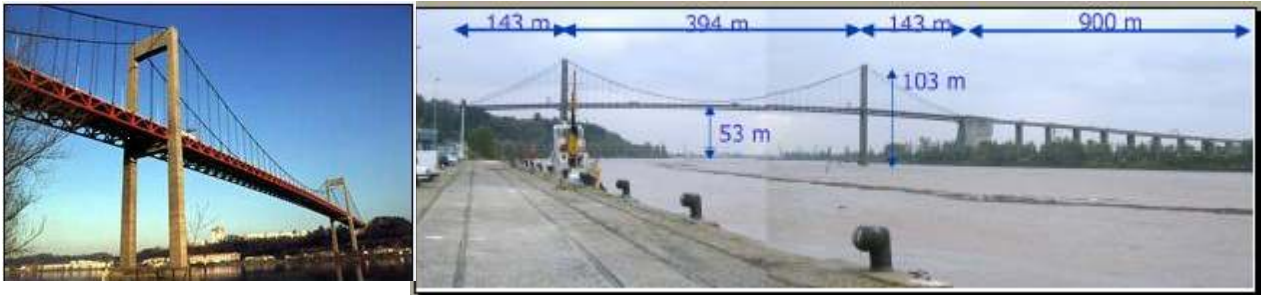
Figure 1- caractéristiques du pont-source SETRA
