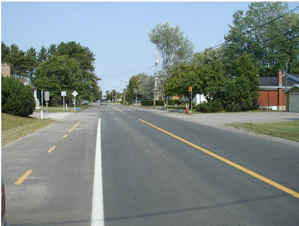
Photo 2 – Saint-Louis de France – Route après travaux d'entretien
