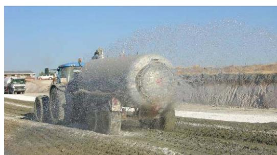
Figura 8. - Tractor cuba para el transporte y el aporte de agua
