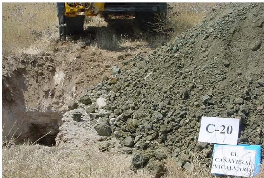
Figura 2. - Material de la formación  $TP_P$  extraído durante la campaña geotécnica
