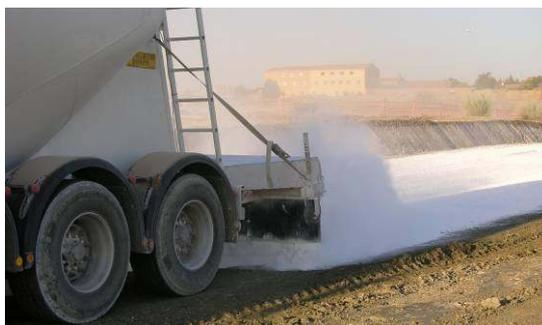
Figura 7. - Camión cisterna de cal con distribuidor/dosificador
