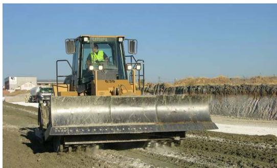
Figura 5. - Maquinaria de extendido y compactación del material
