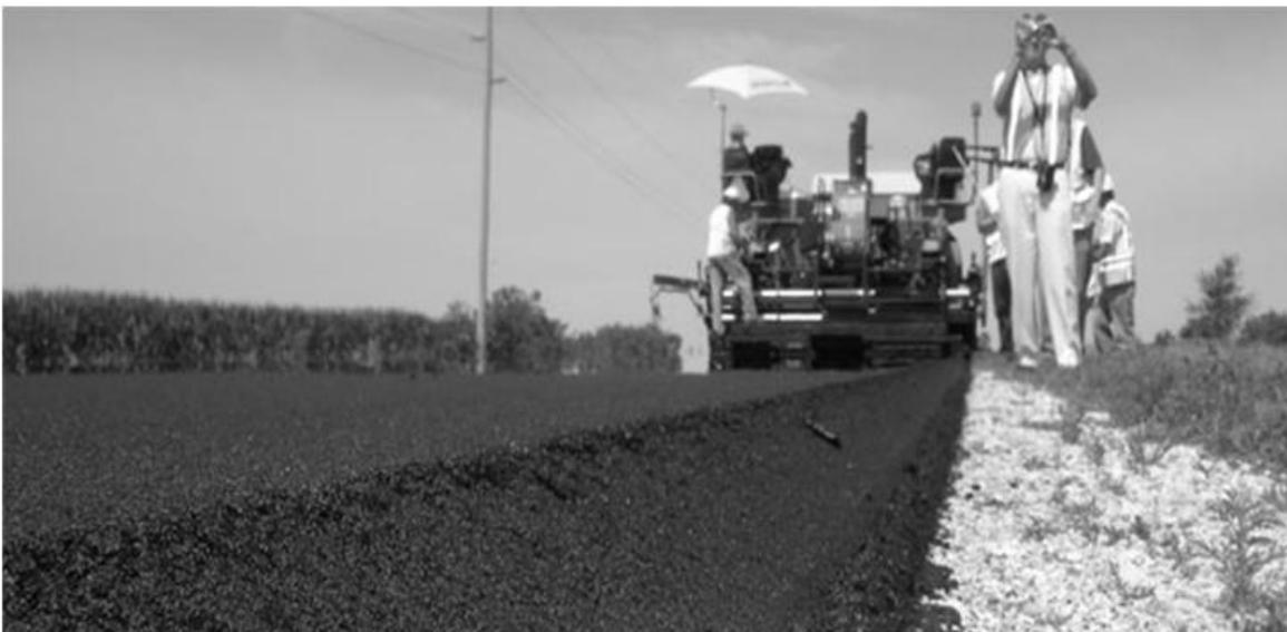
*Le Safety Edge, montré ci-dessus immédiatement après son installation, est un coin incliné à 30 degrés qui est posé à l'extrémité du revêtement pour pallier à la dénivellation entre l'extrémité du revêtement, l'extrémité irrégulière et parfois verticale entre la surface*
