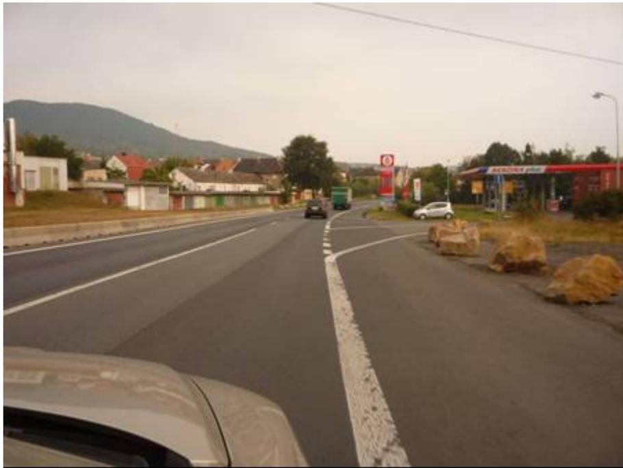
Figure 16 : Route nationale d'importance européenne (I/30) équipée de blocs de pierre au lieu de balises.
