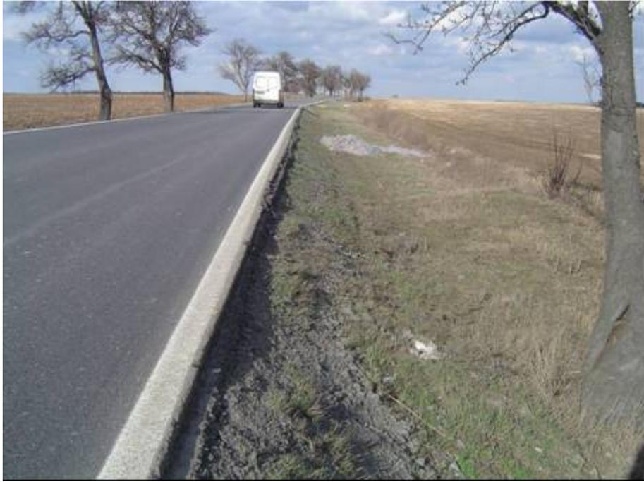
Figure 18 : Absence totale d'accotement le long d'une route très fréquentée dans la banlieue de Prague.
