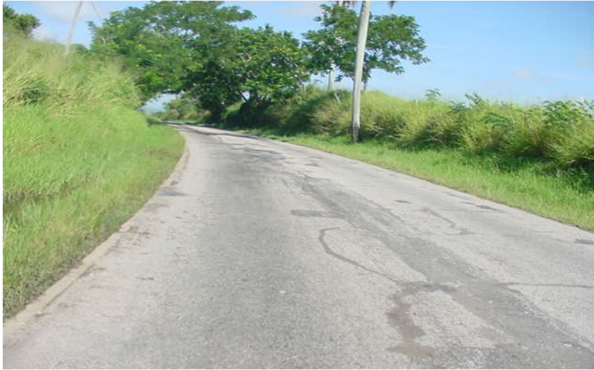
Foto 1, Vista del tramo de carretera inspeccionado.
