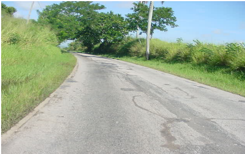
Image 1. Vue de tronçon de route inspectée.
