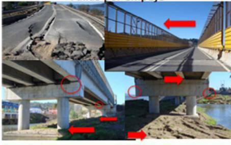
**Colapso por mesa de apoyo insuficiente y movimiento de fundaciones**
