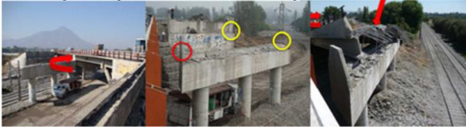
**Daños por corte en Vigas sin travesaño extremo**
