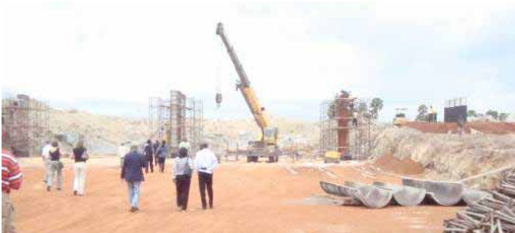
Visita a la sección en construcción Singrobo-Yamoussoukro (Septiembre 2009)
